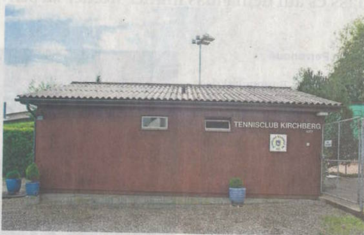
Das alte Gebäude des Tennisclubs Kirchberg soll abgerissen werden. Geplant ist ein Neubau. Foto: Franziska Rothenbühler
